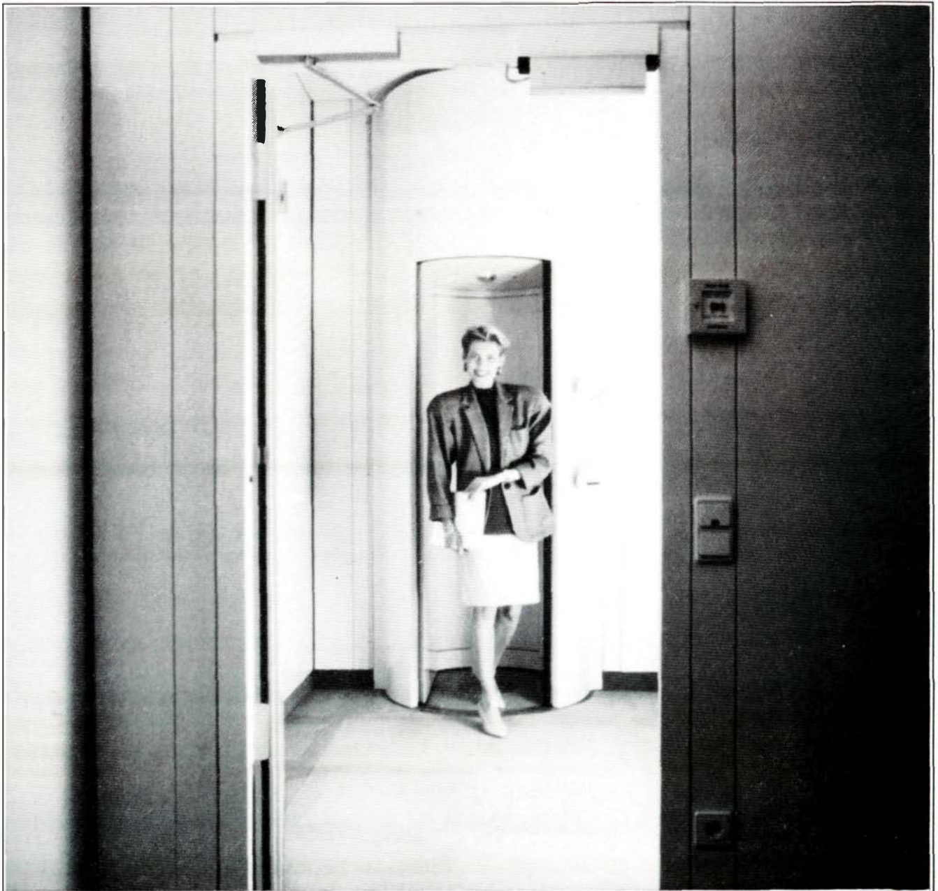
Toegangscontrole in het computergebied; in dit geval met sleutelkaart en sluis
