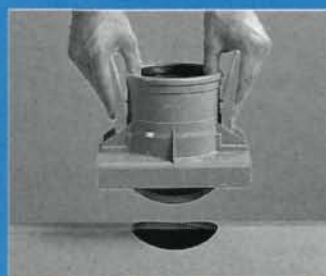
Na boren en afbramen van het gat kan de knevelinlaat er direct in worden gedrukt.
