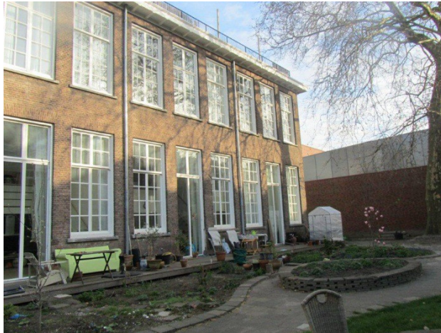
De voormalige Hooimanschool met gezamenlijke binnenterrein.
