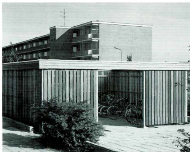
Figuur 65. Een prefab fietsenstalling.
