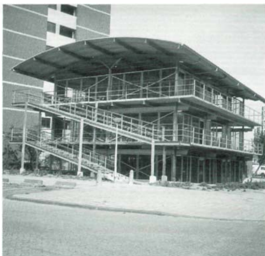
Figuur 77. Moderne, afsluitbare fietsenstalling bij studentenflat.
