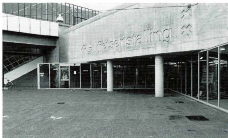
Figuur 18. Bij station Amsterdam RAI is een 'bewaakte stalling nieuwe stijl' gemaakt. Deze wordt gecombineerd met een ruime winkel en werkplaats. In perioden dat er geen bewaking is, wordt een deel van de stalling elektronisch afgesloten.
