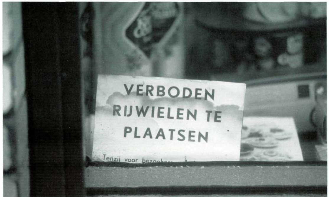
Figuur 27. Particulieren kunnen verbieden dat fietsen tegen de gevel van hun woning worden geplaatst. De handhaving van een dergelijk verbod is echter voorbehouden aan de politie.
