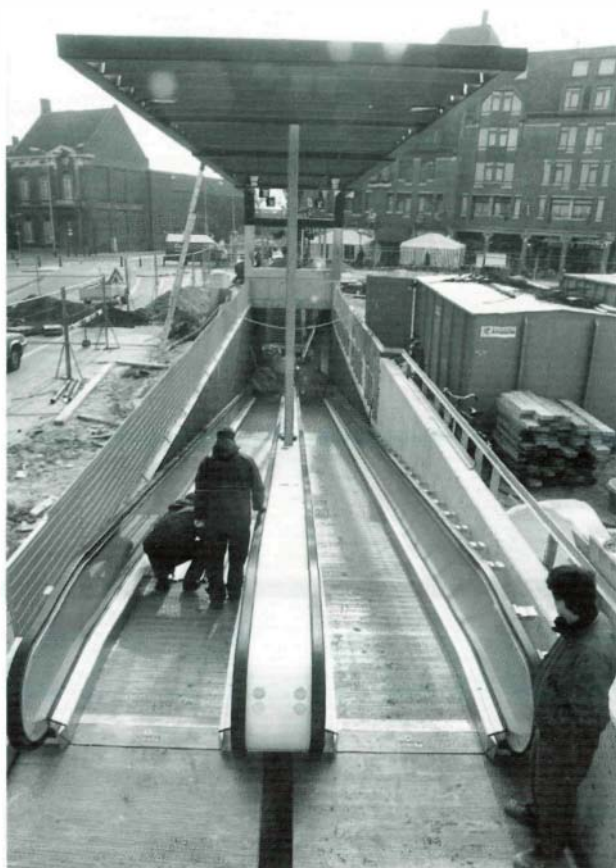
Figuur 90. Bij fietsenstalling 'Onder de heuvel' in Tlburg wordt het hoogteverschil overbrugd met twee rolpaden.
