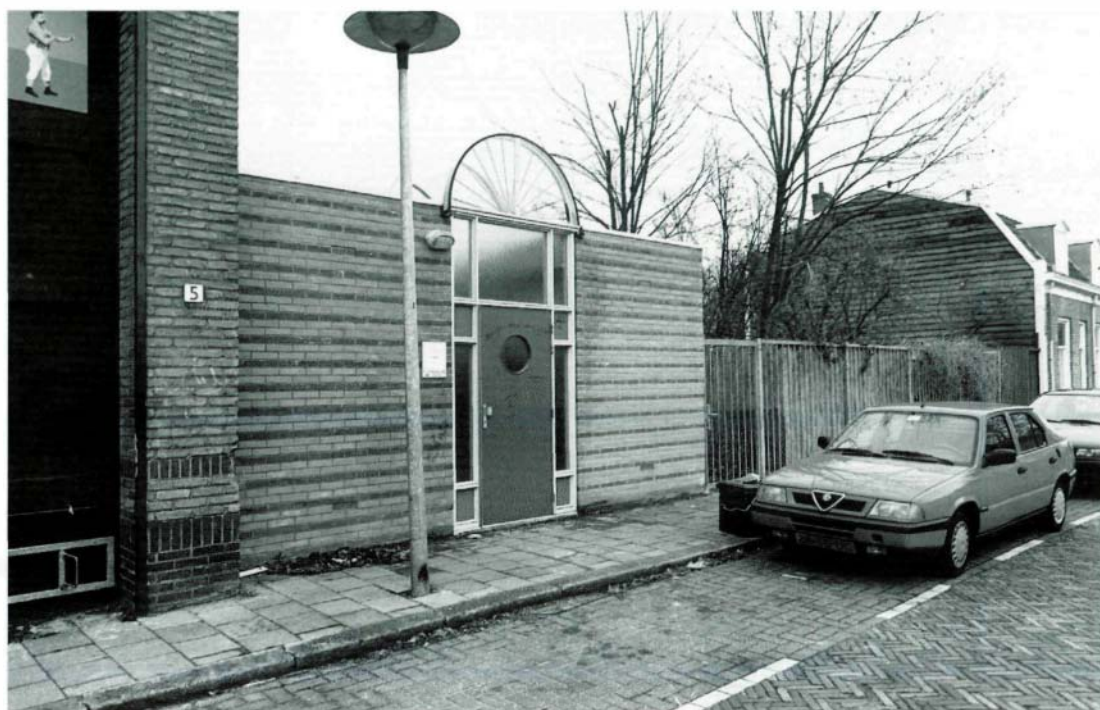
Figuur 54. In de Vogelenbuurt in Utrecht zijn nieuwe buurtstallingen gebouwd.
