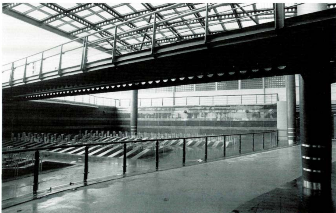
Figuur 23. Een ruime, nieuwe stalling in aanbouw.
