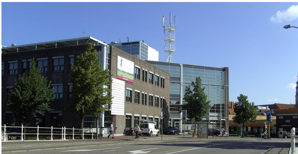
Koestraat (linker gebouw)
