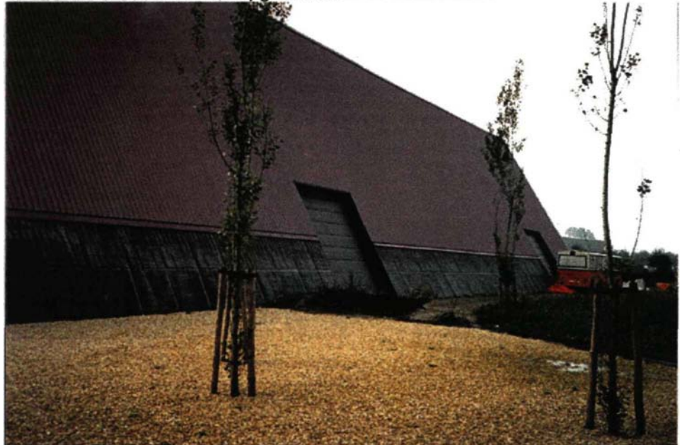
Foto 4 Entrees voor de distributie opgenomen in de achterwand
