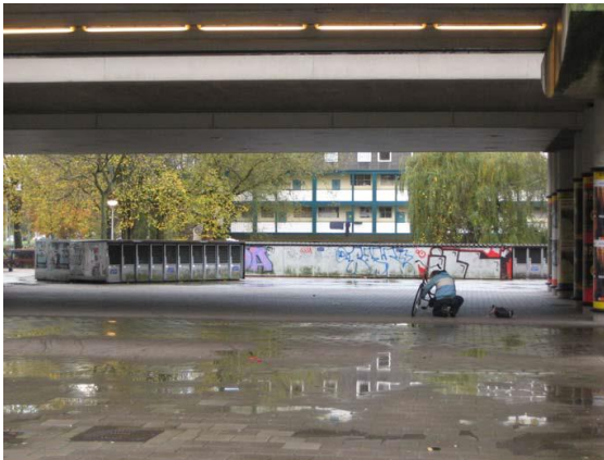
Fietskluizen vormen barrières en zijn slecht onderhouden (2007)
