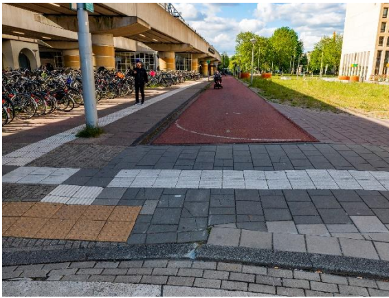
Ontoegankelijkheid door verzakkingen en abrupt stoppend fietspad Verkeersobstakels voor fietsers en voetgangers
