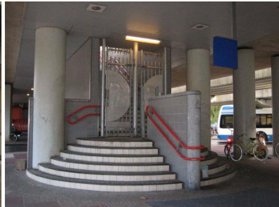
Afgesloten trappen worden hangplekken en ogen onveilig (2007)
