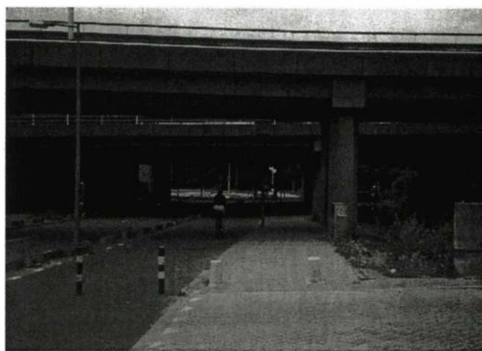
De Schipluidenlaan onder het viaduct van de ringweg door, huidige situatie
