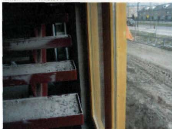
Vrije ruimten tussen trappenhek(panelen) en traptreden
