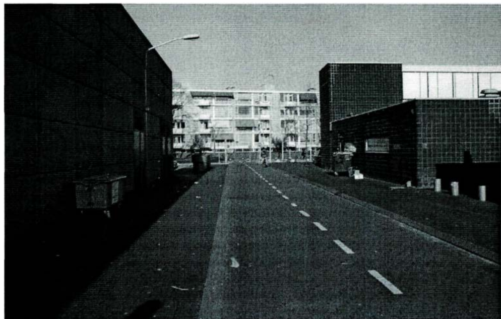
Blinde muur van de Konmar, Duindoorn
