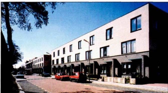
Stedelijke wand van 15 kubuswoningen als begrenzing van de wijk. Een 'setback' aan de achterzijde sluit aan op de schaal van de bebouwing in de rest van de wijk.
