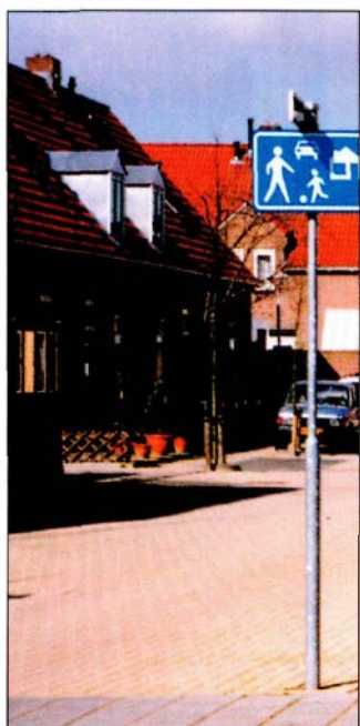
Bestaande woningen in de wijk zijn hoogniveau gerenoveerd in lijn met het Politiekeurmerk Veilig Wonen®.
