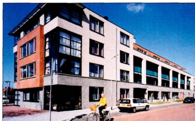
Een van de twee appartementengebouwen in keurmerkwijk Bakkum. Hoog metselwerk moet opklimmen vanaf de begane grond frustreren.
