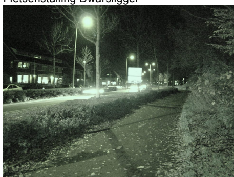
Gebrekkige verlichting op het fietspad langs de Conradstraat
