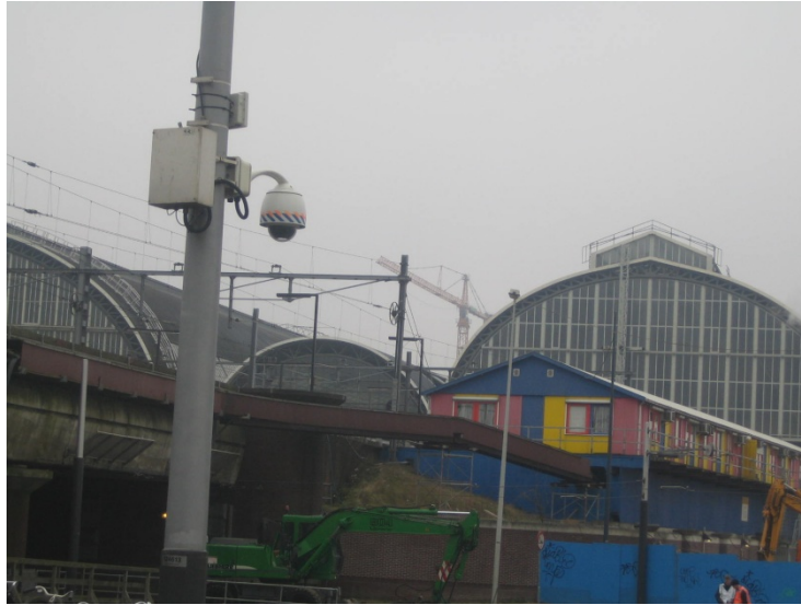
De bouwwerkzaamheden aan de achterzijde van het station
