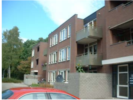
Gestapelde bouw met centrale portiek; inbraak door flipperen
