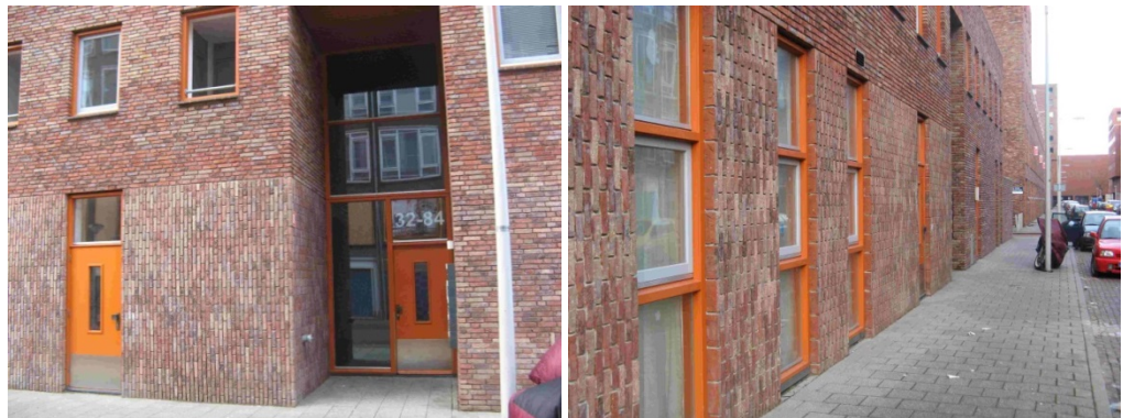
Foto: (links) een inspringend portiek, draagt niet bij aan de zichtbaarheid (rechts); geen sociale ogen op de straat en gebrek aan eenduidigheid (Dus: voorkomen inspringen in rooilijnen). Het grote euvel is hier dat mensen de ramen gaan blinderen, omdat mensen pal langs de gevel lopen.
