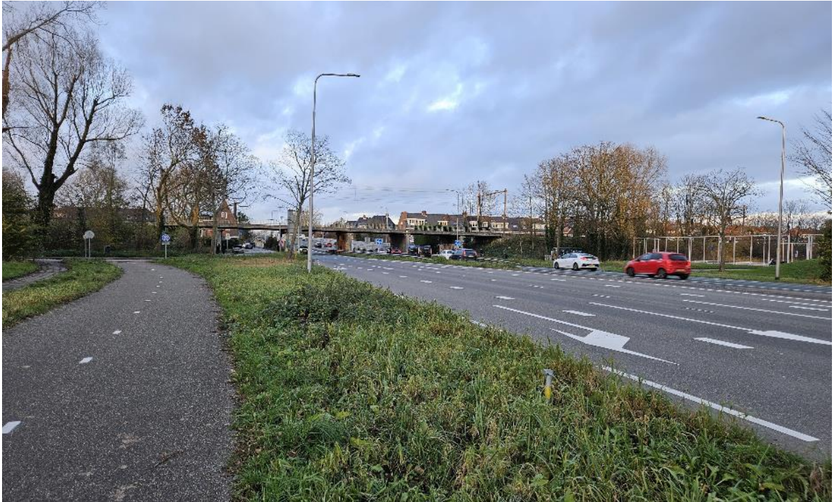
Randweg iets meer naar links/noorden gezien met zicht op spoorbrug (hoogte 4 meter)
