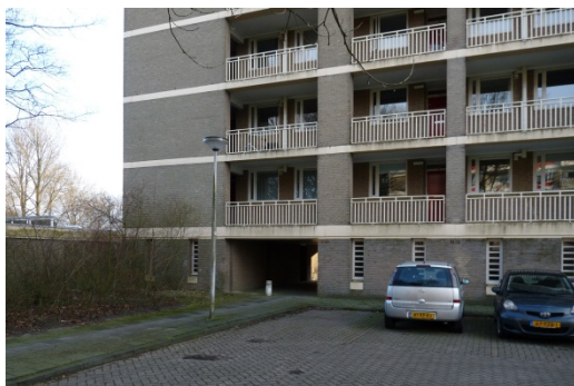
Onderdoorgang flats Ringweg Randenbroek
