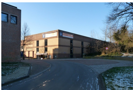
Achterzijde Flint en parkeergarage
