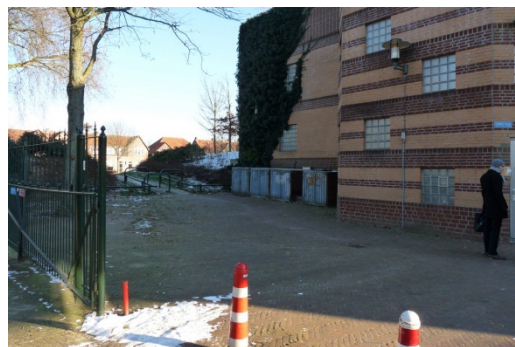
Achterzijde parkeergarage met doorgang naar plantsoen
