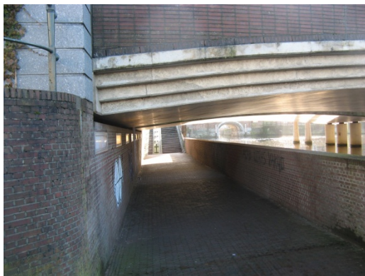
Onderdoorgang tunnel Grote Koppel
