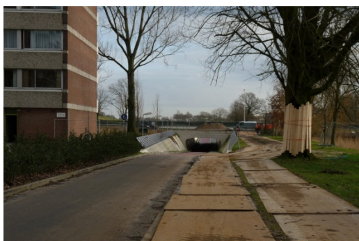
Tunnel onder A28, gezien richting Leusden
