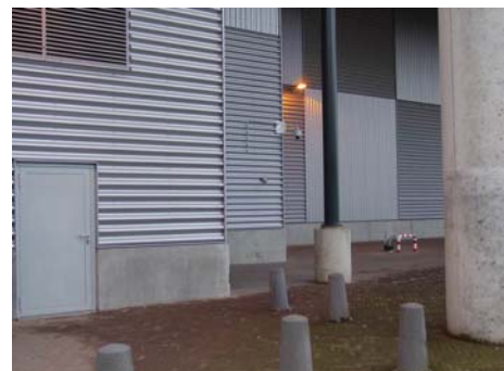
Verspringende wand onder de Arena
