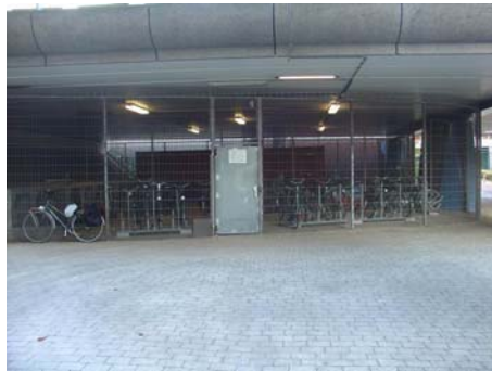
Fietsenstalling onder viaduct Bijlmerdreef
