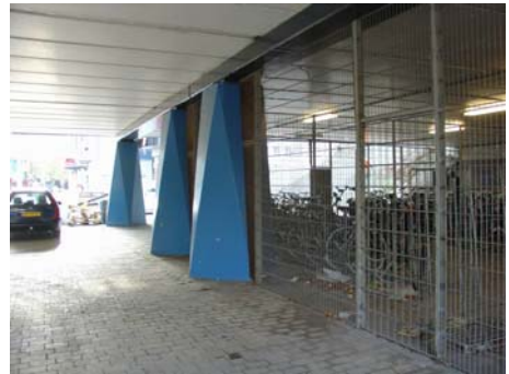
Fietsenstalling onder viaduct Bijlmerdreef
