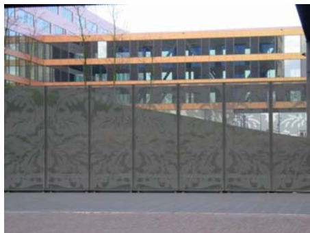
Positief voorbeeld van hekwerk (ING kantoor Bijlmerdreef)
