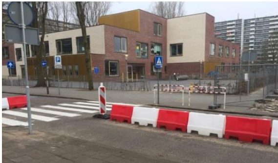
Oversteekplaats Satellietbaan: wordt 2 meter verplaatst
