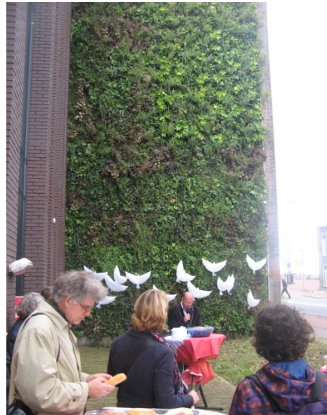
Blinde muur Van Diemenstraat Amsterdam (Foto: DSP-groep)
