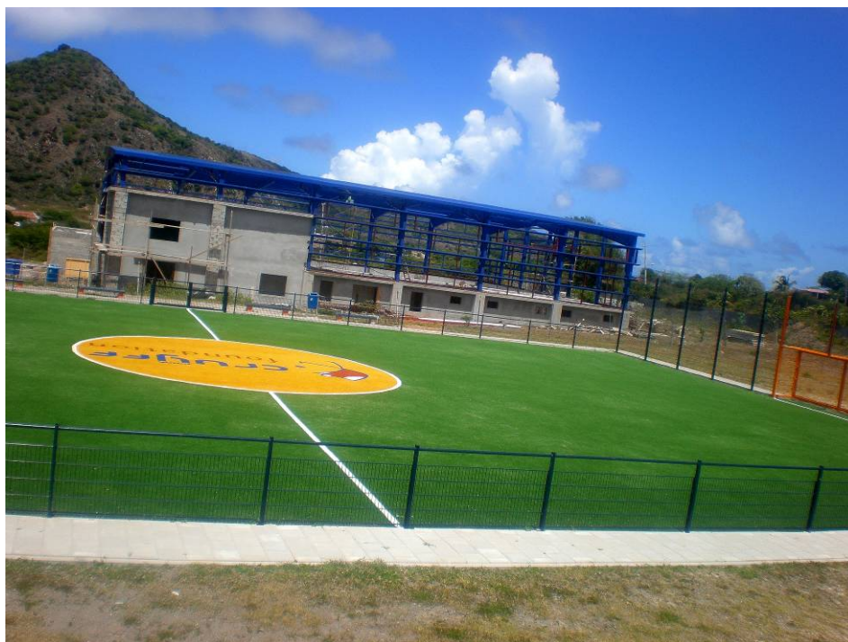
Cruyff court en sporthal in aanbouw in Oranjestad
