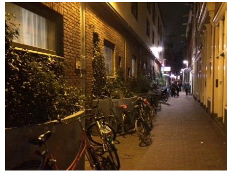
Figuur 5.2 Aandachtspunt is dat het vergroenen geen obstakels oplevert waar fietsen tegen worden geparkeerd (en die beschutting voor wildplassen bieden) 15
