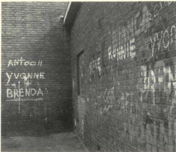
Schoonmaken van deze muren in de Lod. van Deijsselstraat kost f 1200,—
