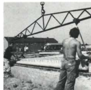
Plaatsing van een MW 21 isolatievloer
