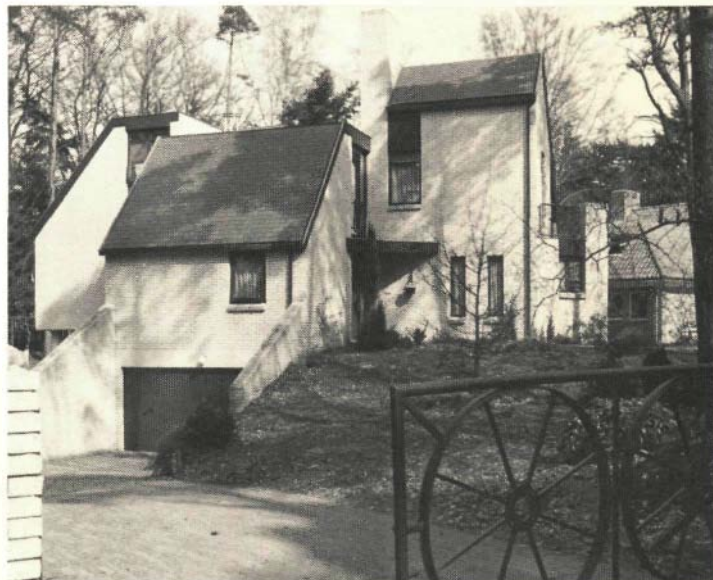
Een uiterst moderne woning, door AMBACHT BV gebouwd naar een ontwerp van Architectenbureau A. J. Kloosterman BV BNA, die ook de directie voerde.
