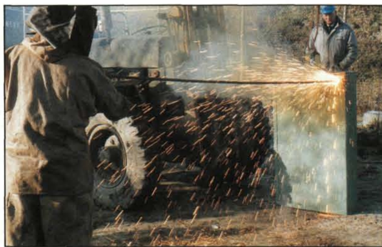
Brandproef met de thermische lans op het Martens prefabpaneel
