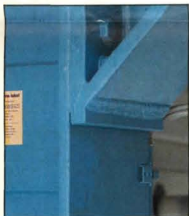
Detail staalconstructie behandeld met brandwerend Unitherm verfsysteem (hoofdwerkplaats NS Tilburg).
