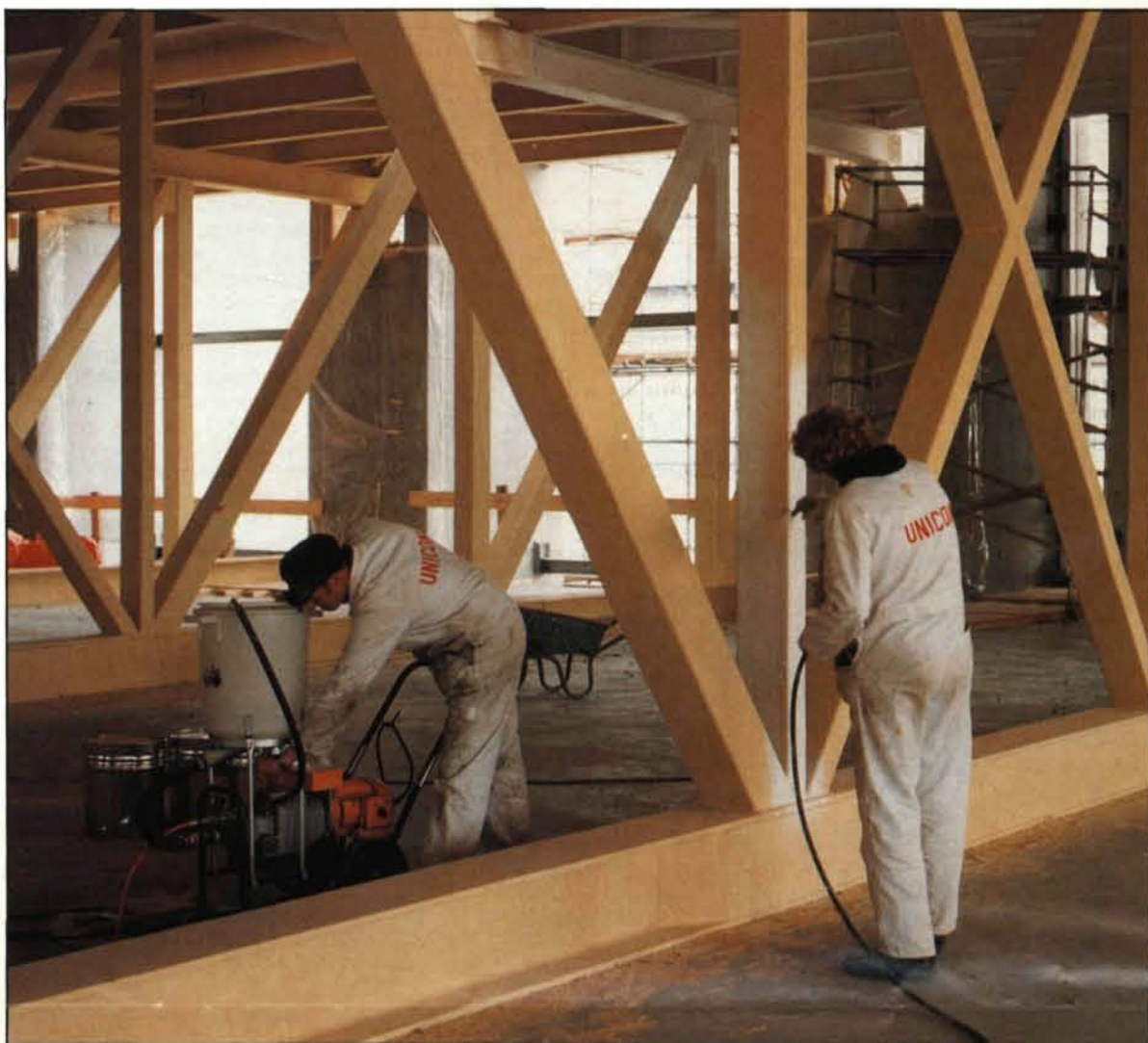
Nieuwbouw researchlaboratorium Philips Eindhoven. Unicon medewerkers brengen brandwerende verfsystemen aan.
