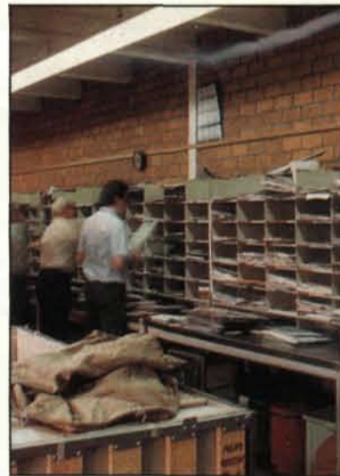
Postgebouw Philips Eindhoven. Ligger- en kolombekleding met Rockpan brandwerend plaatmateriaal. Kolommen zijn afgewerkt met stalen cassettes.
