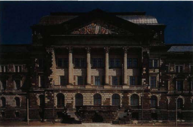
△ 1 Südansicht (Ebseite): Mittelrisalit mit Fliesengemälde im Tympanon (Giebelfeld)
