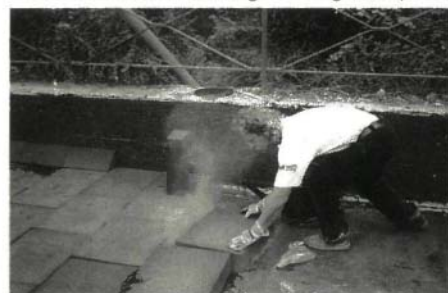
△ 3 Foamglasplatten werden im Heißbitumen verlegt
