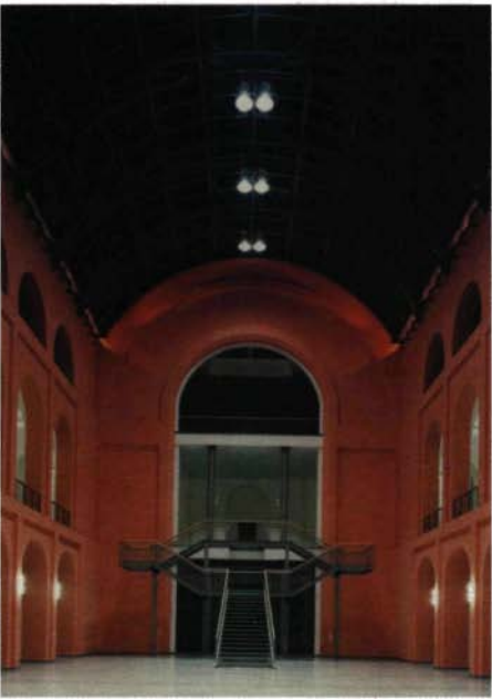
Die ehemals prunkvolle Haupthalle im Sächsisch-Königlichen Finanzministerialgebäude in Dresden wurde im Zweiten Weltkrieg in Teilen zerstört und im Zuge der Sanierung des Gebäudes von den Planern in einer schlichten, reduzierten Formensprache rekonstruiert (Seite 10). Auch die zentrale Stahltreppe mit Glasstufen ist einer historisch an dieser Stelle vorhandenen Steintreppe nachempfunden. Die Konstruktion dieser Treppe sowie die der Stadtbibliothek Biberach und der Berger-Villa in Leipzig werden unter der Rubrik »Details« vorgestellt (Seite 36) Foto: Jörg Schöner, Foto-Designer BFF, Dresden
