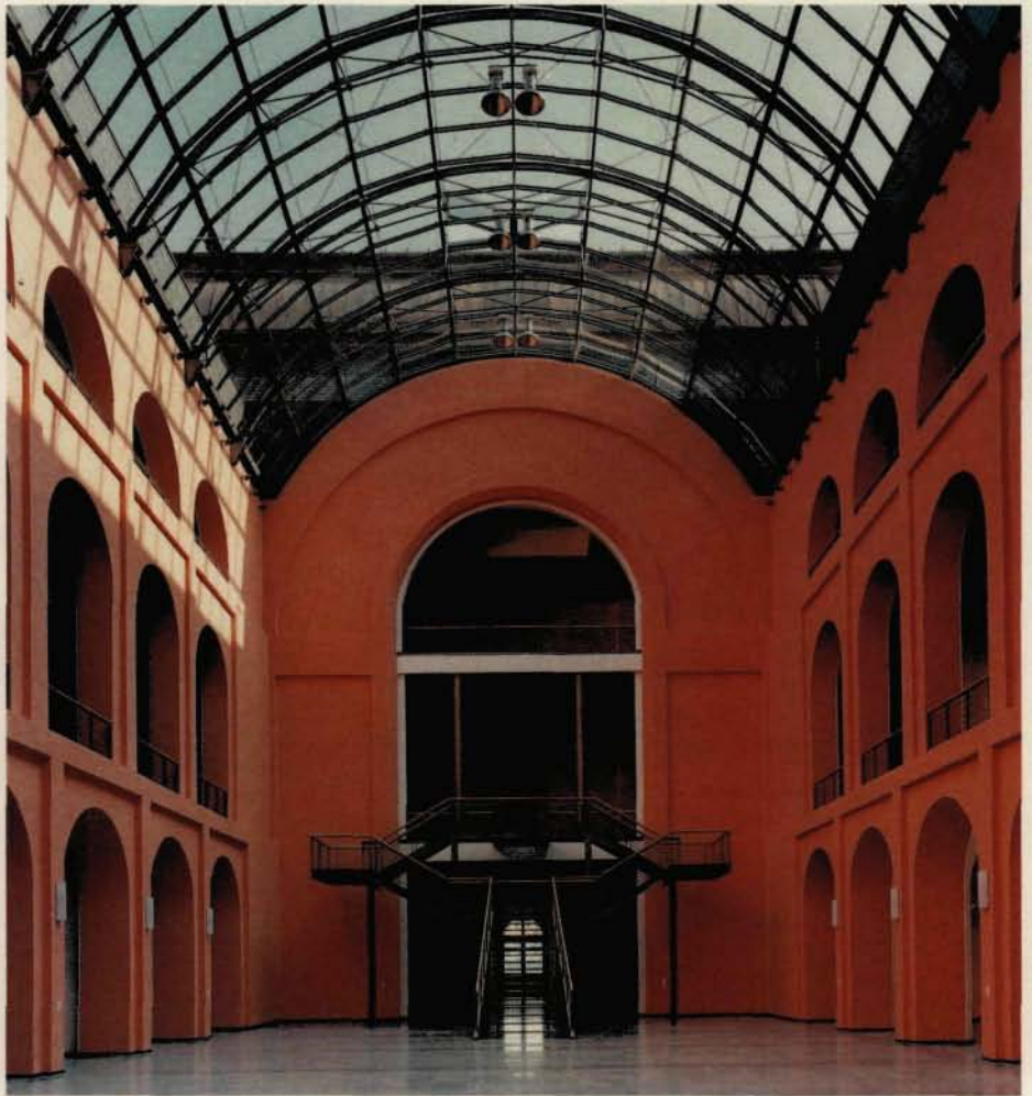
△ 5 Sanierte Eingangshalle mit an der historischen Form angelehnter, jedoch modern gestalteter Glastreppe
