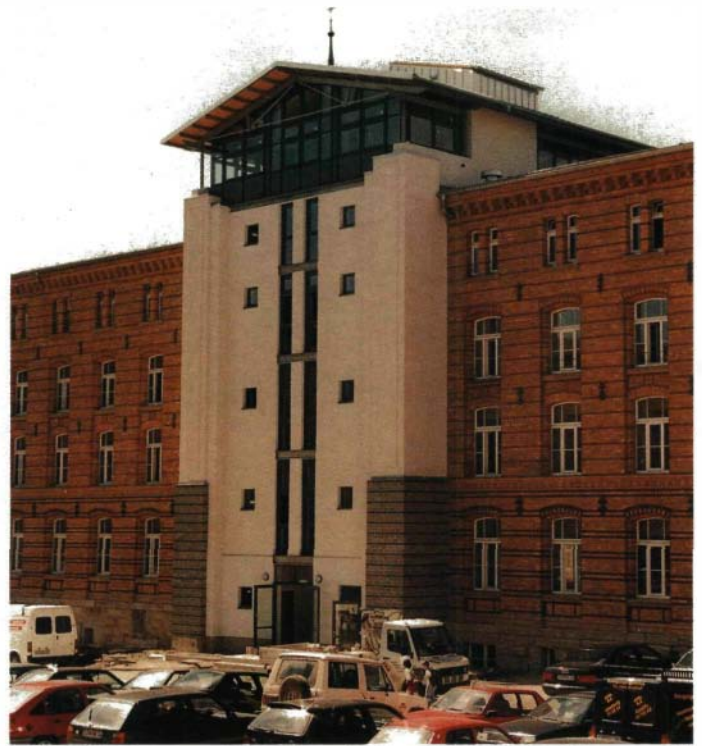
△ 3 Ansicht des neuen Mittelteil von der Hofseite Fotos: Körner, Apolda
