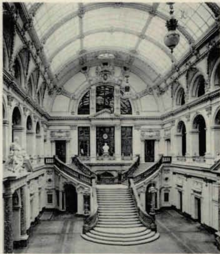
△ 4 Historisches Bild der Eingangshalle mit Steintreppe
