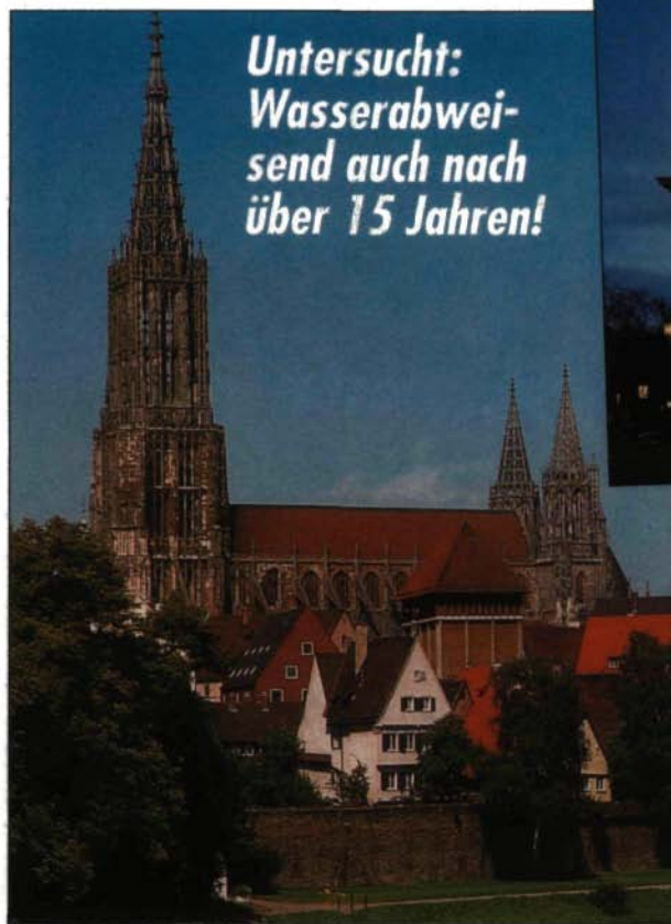
Ulmer Münster, Steinfestigung und Imprägnierung im Funcosil® Fassadenschutz-System.
