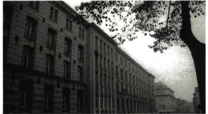
△ 4 Zimmermannsbau vor Sanierung mit dem Mittelteil aus den 40er Jahren
