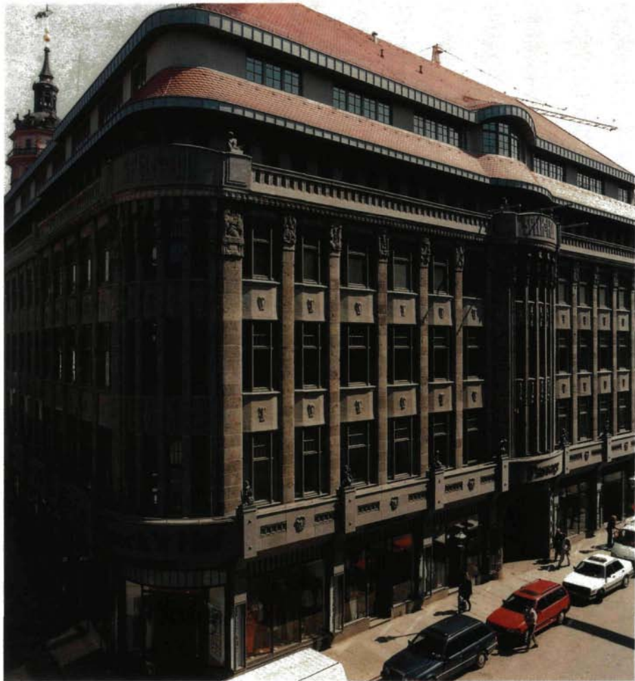
1 Das als »Specks Hof« bezeichnete Messegebäude in Leipzig ist ein Beispiel dafür, daß sich die stilgerechte Sanierung historischer Bausubstanz in jeder Hinsicht lohnt. Die Schaufenster im Erdgeschoß erhielten eine filigrane Profilierung in Aluminium-Systemtechnik mit Holzeinlage 2 Das Gebäude während der Sanierungsarbeiten: Das Dachgeschoß mit Lichthöfen wird rekonstruiert Foto: Schüco International, Bielefeld
