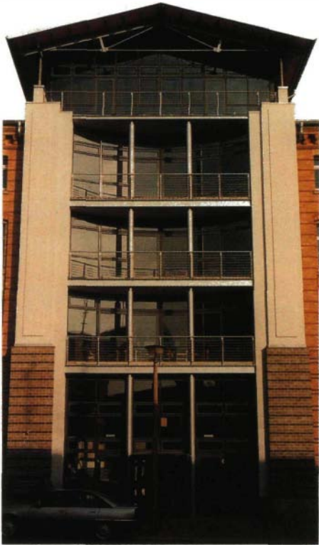
△ 1 Ansicht des neuen Mittelteil zur Straße hin
