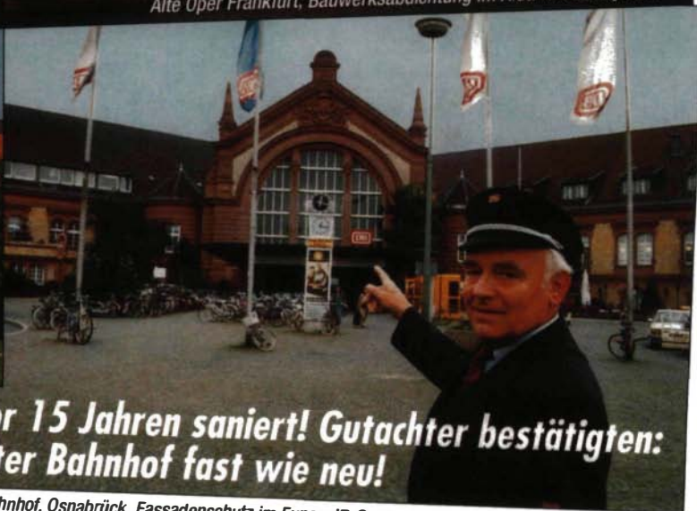
Turbahnhof, Osnabrück, Fassadenschutz im Funcosil®-System.
