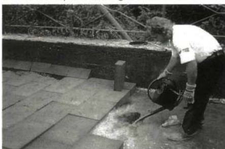
△ 2 Auftrag von Heißbitumen auf die Stahlbetondecke
