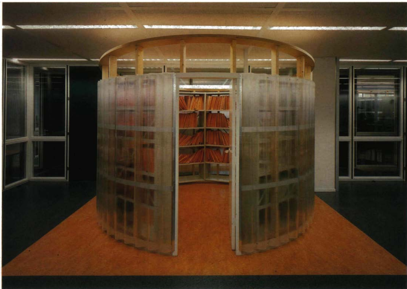
△ 4 Die aus sinusprofilierten Stegdoppelplatten konstruierten Archivräume bilden runde Leseinseln am Gang
