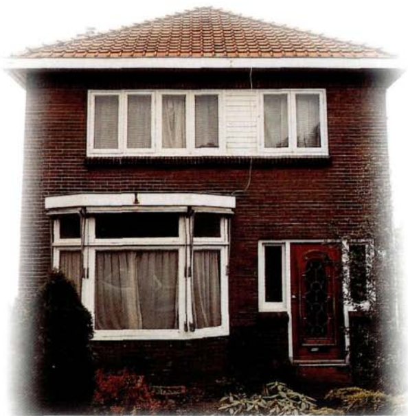
Woonhuis in de Bilt vóór de renovatie...
