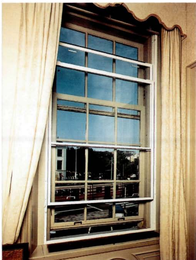
Oude panden hebben vaak verticale schuiframen, de oplossing is dus ook een schuivend achterzetraam
