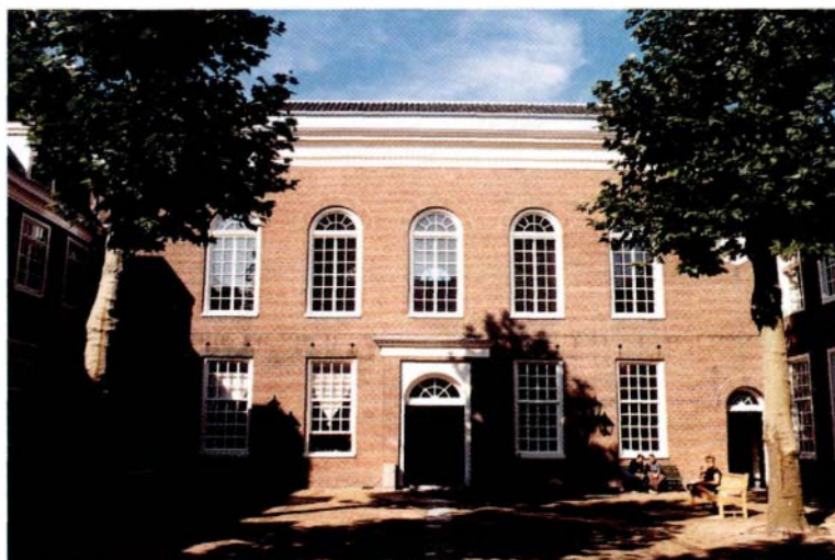
Alles geïsoleerd met achterzetramen, maar het gevelbeeld blijft onaangestast
