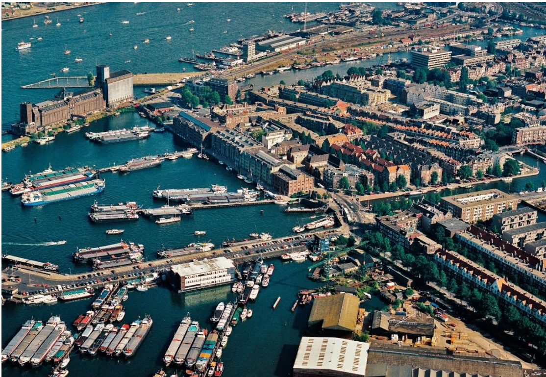
Oude Houthaven medio jaren 80 met Silo's, Veem en de drijvende Schippersbeurs aan de Pontsteiger (wit dak midden)
