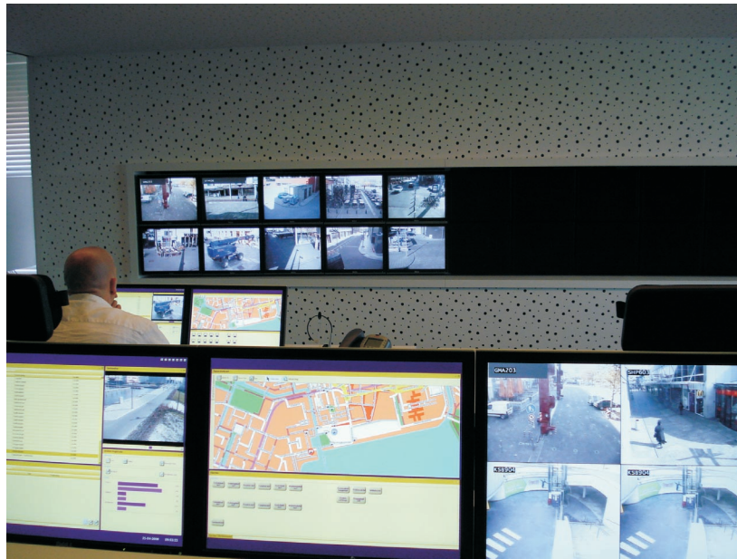
Afbeelding 2.4.7.7-7: Hier in Almere ziet de toezichthouder niet alleen het camerabeeld, maar worden ook alle incidenten geregistreerd in een managementsysteem. (Foto: VCS Observation.)
