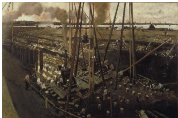
Bouw van het Veem. Heiwerk aan de Van Diemenstraat Breitner 1897 Bron: https://www.stedelijk.nl/nl/collectie/3178-george-hendrik-breitner-heiwerk-aan-de-van-diemenstraat-(bij-het-ij)
