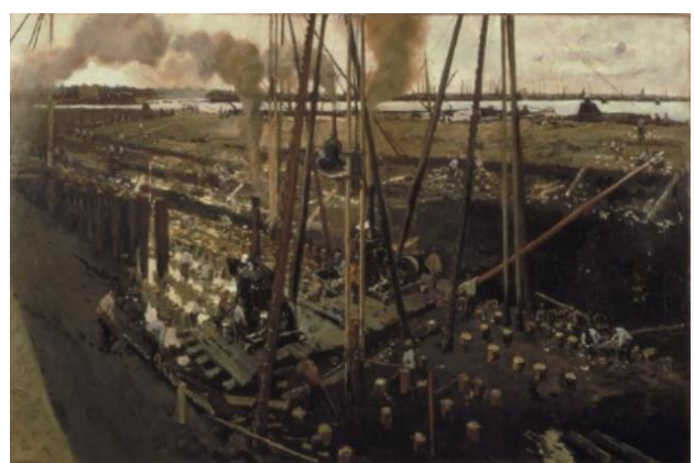
Heiwerk aan de Van Diemenstraat, Breitner 1897. Bron: https://www.stedelijk.nl/nl/collectie/3178-george-hendrik-breitner-heiwerk-aan-de-van-diemenstraat-(bij-het-ij)
