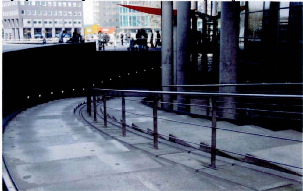
Afbeelding B.4.4 Ingang fietsenstalling in zicht van hoofdentree. Haagse Hogeschool
